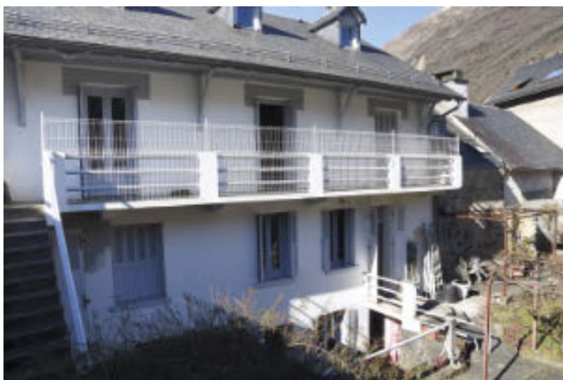
La Maison vue du parking rue du Calihour
