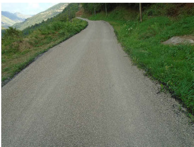
Prise de vue après travaux (L. MAJESTÉ)
