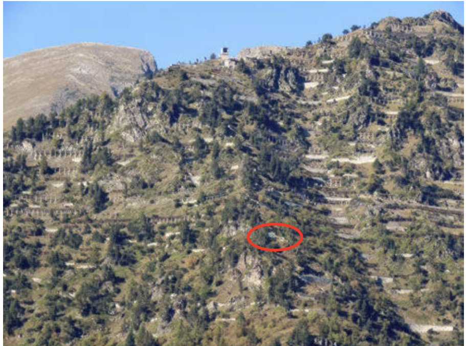
Vue rapprochée des nombreux ouvrages de protection Photographie Joël ADAGAS.
