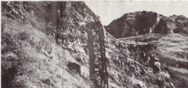
Ce pylône de ferrailles, l'une des verrues de Bue Cestrède, enlevée par EDF.
