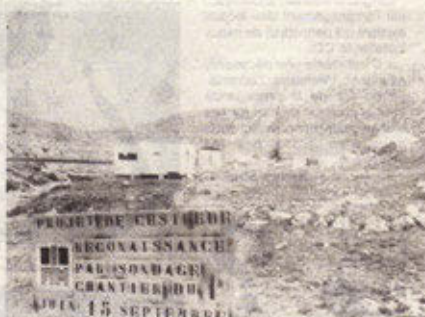
Les travaux de sondage se poursuivent jusqu'au 15 septembre.
