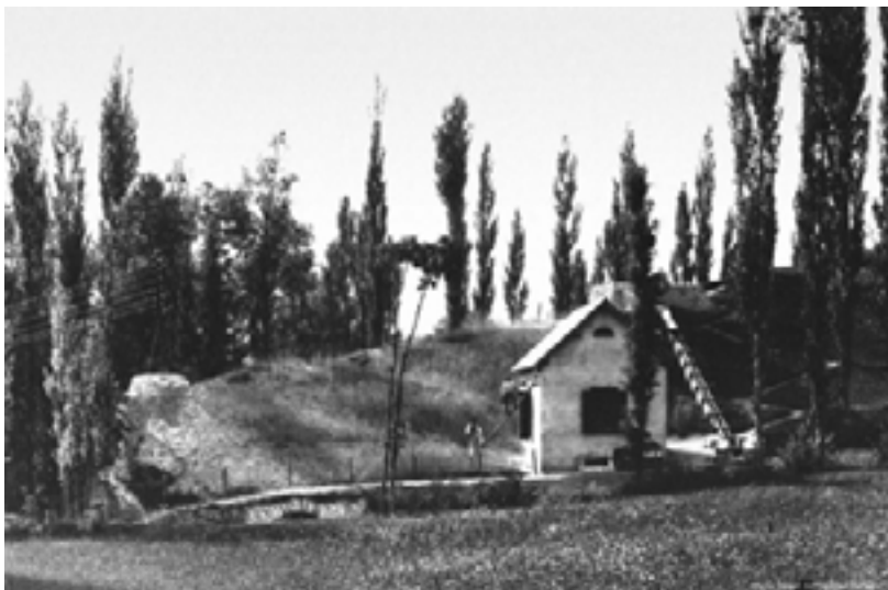
Usine électrique - Avant
