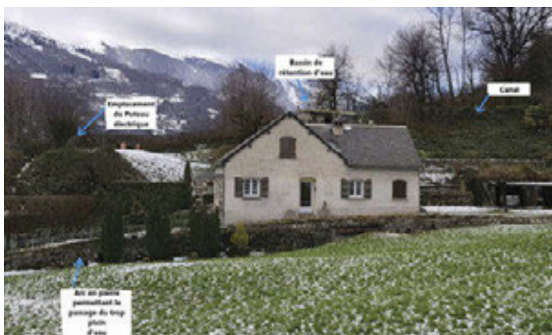
Usine électrique - Après
